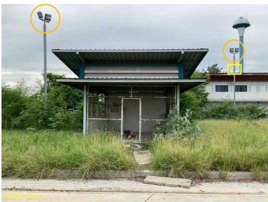
ติดตั้งโคมไฟส่องสว่าง และกล้องวงจรปิด (CCTV) โดยรอบสถานีบริการ ป้อมยาม และบริเวณอาคารสำนักงาน
