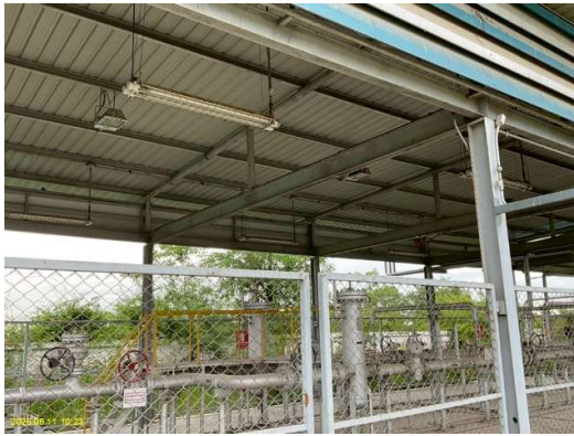
ระบบไฟฟ้าที่ใช้ภายในสถานีบริการเป็นชนิดป้องกันการระเบิด (Explosion Proof)
