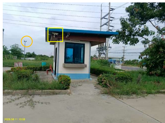
ติดตั้งโคมไฟส่องสว่าง และกล้องวงจรปิด (CCTV) โดยรอบสถานีบริการ ป้อมยาม และบริเวณอาคารสำนักงาน
